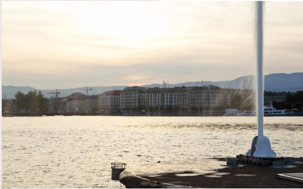
Plattform über der Pumpenanlage des Jet d'eau
